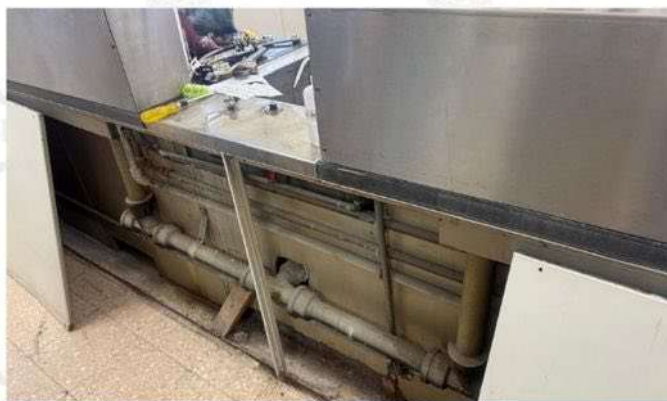
Rehabilitación de línea de drenaje en tarjas de L5
