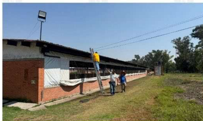
Colocación de reflectores en módulo de aves
