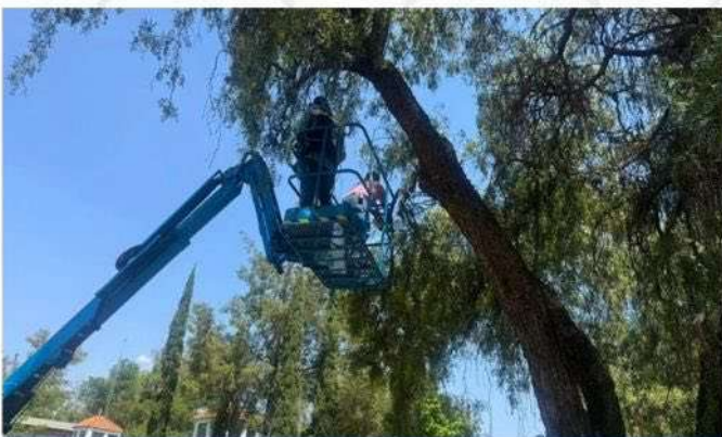
Trabajos de iluminación exterior
