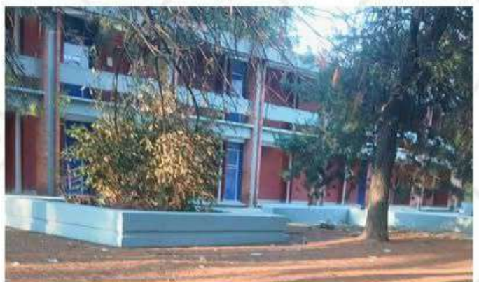
Resane y pintura en áreas comunes de MVZ
