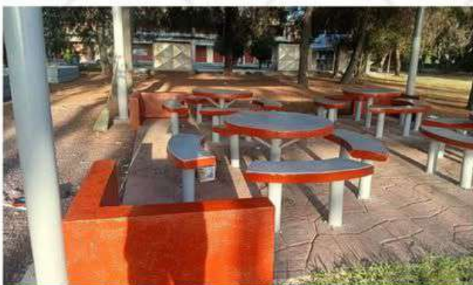
Resane y pintura en áreas comunes de MVZ
