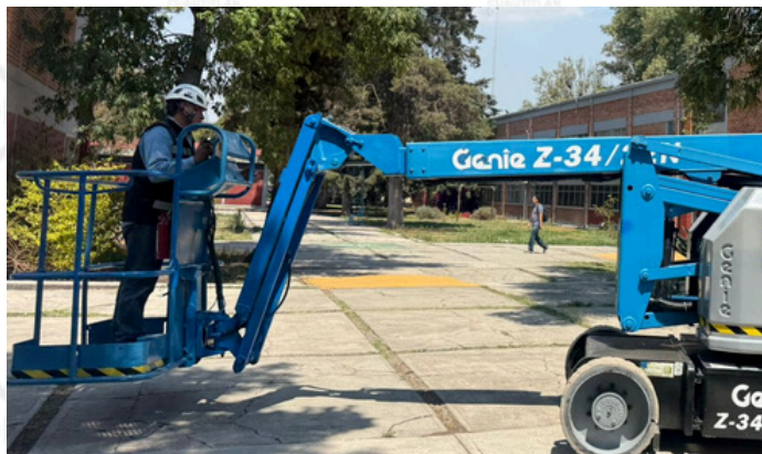
Inicios de trabajo de iluminación exterior
