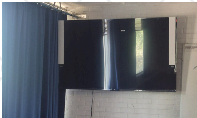
Colocación de pantallas en Administración y Contaduría
