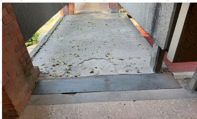
Colocación de tapas juntas en MVZ
