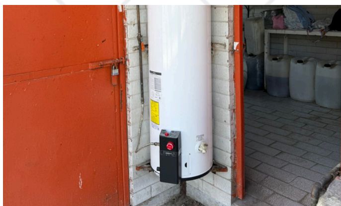
Colocación de boiler en módulo Caprinos
