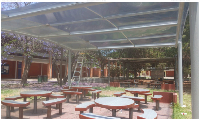
Restauración de pérgola en MVZ
