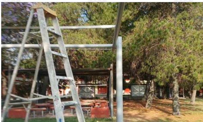
Inicio de trabajos de pérgolas en veterinaria
