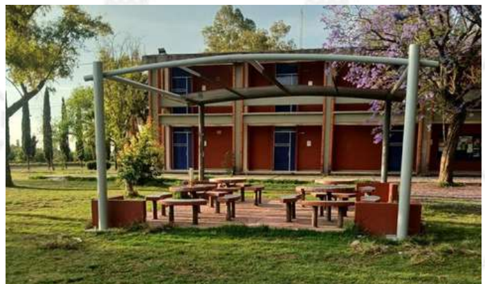
Inicio de trabajos de pérgolas en veterinaria
