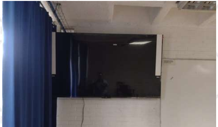
Colocación de pantallas A6
