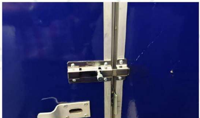
Cambio de cerradura en baños
