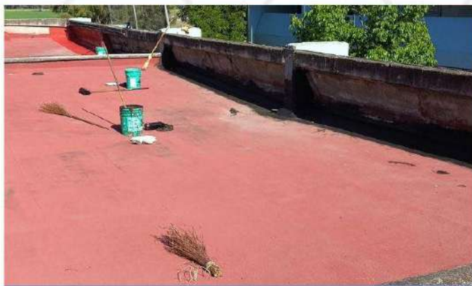
Impermeabilizante de A6
