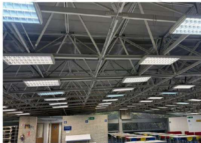
Cambio de luminaria
