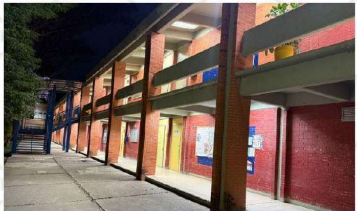
Luminaria en edificios de MVZ
