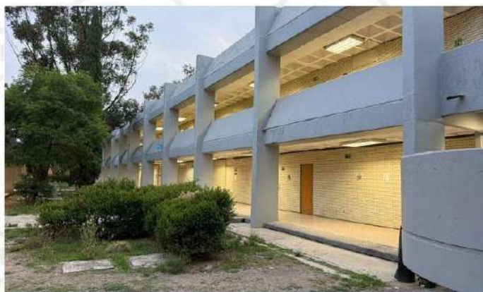
Luminaria en edificio
