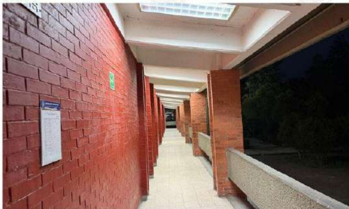
Resane en forro de columnas en MVZ
