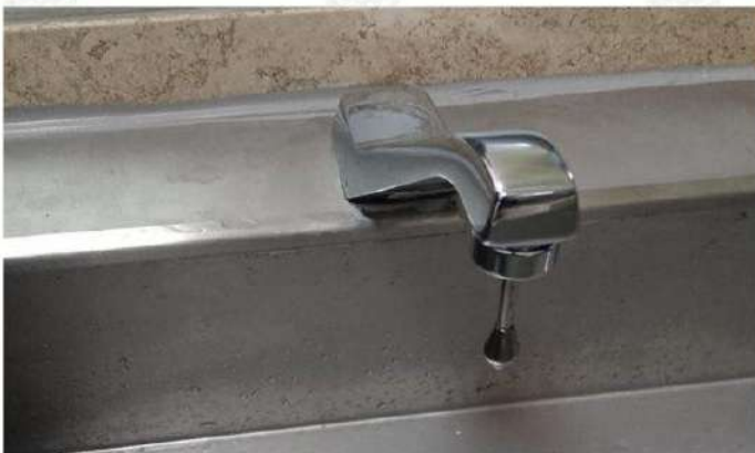
Reparación de llaves
