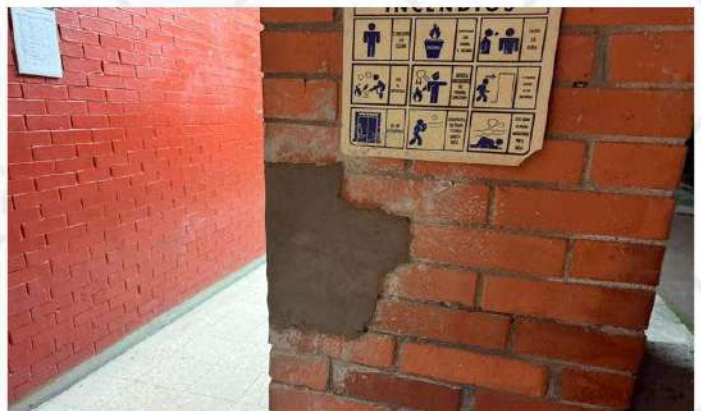
Resane en forro de columnas en MVZ
