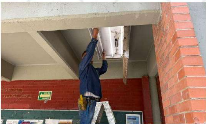
Cambio de luminarias
