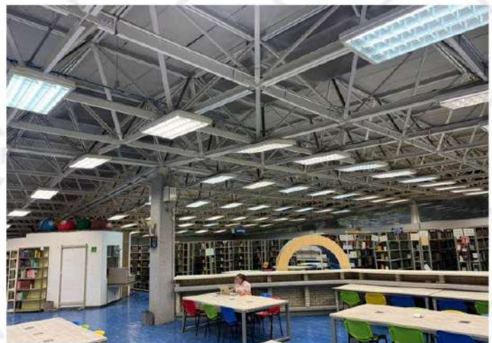
Cambio de luminaria
