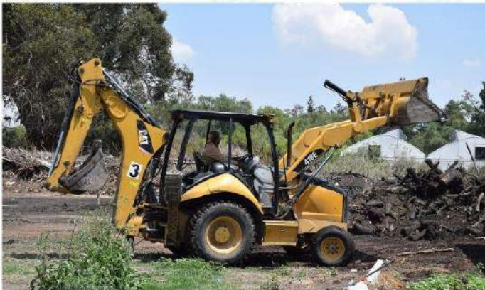
Avance de limpieza en el área de desechos
