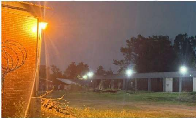
Luminaria en el Rancho
