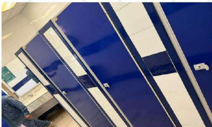
Rehabilitación de baños en A3
