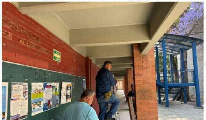
Cambio de luminarias
