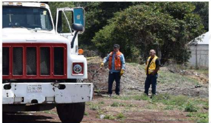
Avance de limpieza en el área de desechos
