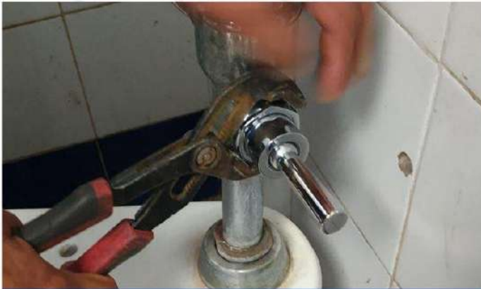
Reparación de sanitarios
